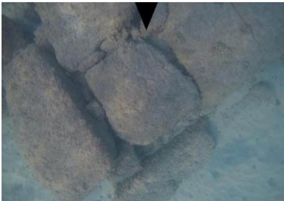
Πυκνά κατασκευαστεί τοιχοποιία της Δομής VIII κάτω από το νερό. Πίστωση: Κωνσταντίνος Merkouris / CC BY 4.0
